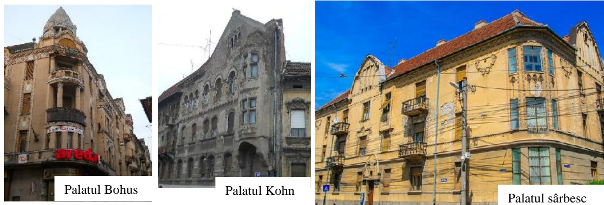
Figura 17b. Exemple de palate din Zona monumentelor protejate Arad care necesită lucrări de reabilitare (poze realizate în teren)
