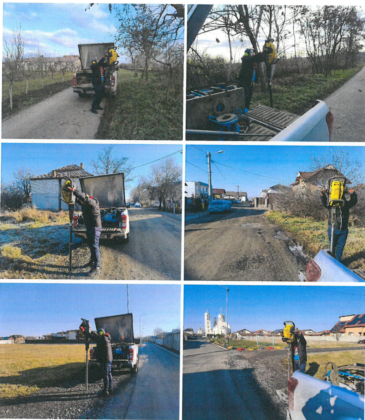
Figura 22. Realizare foraje geotehnice
