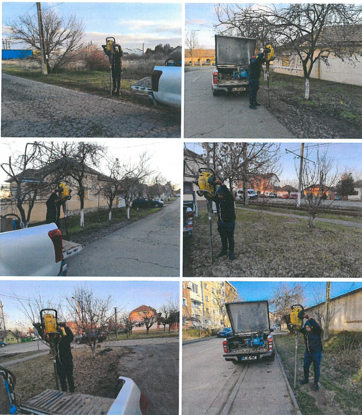
Figura 26. Realizare foraje geotehnice
