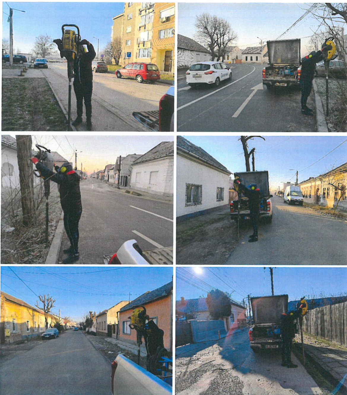
Figura 27. Realizare foraje geotehnice
