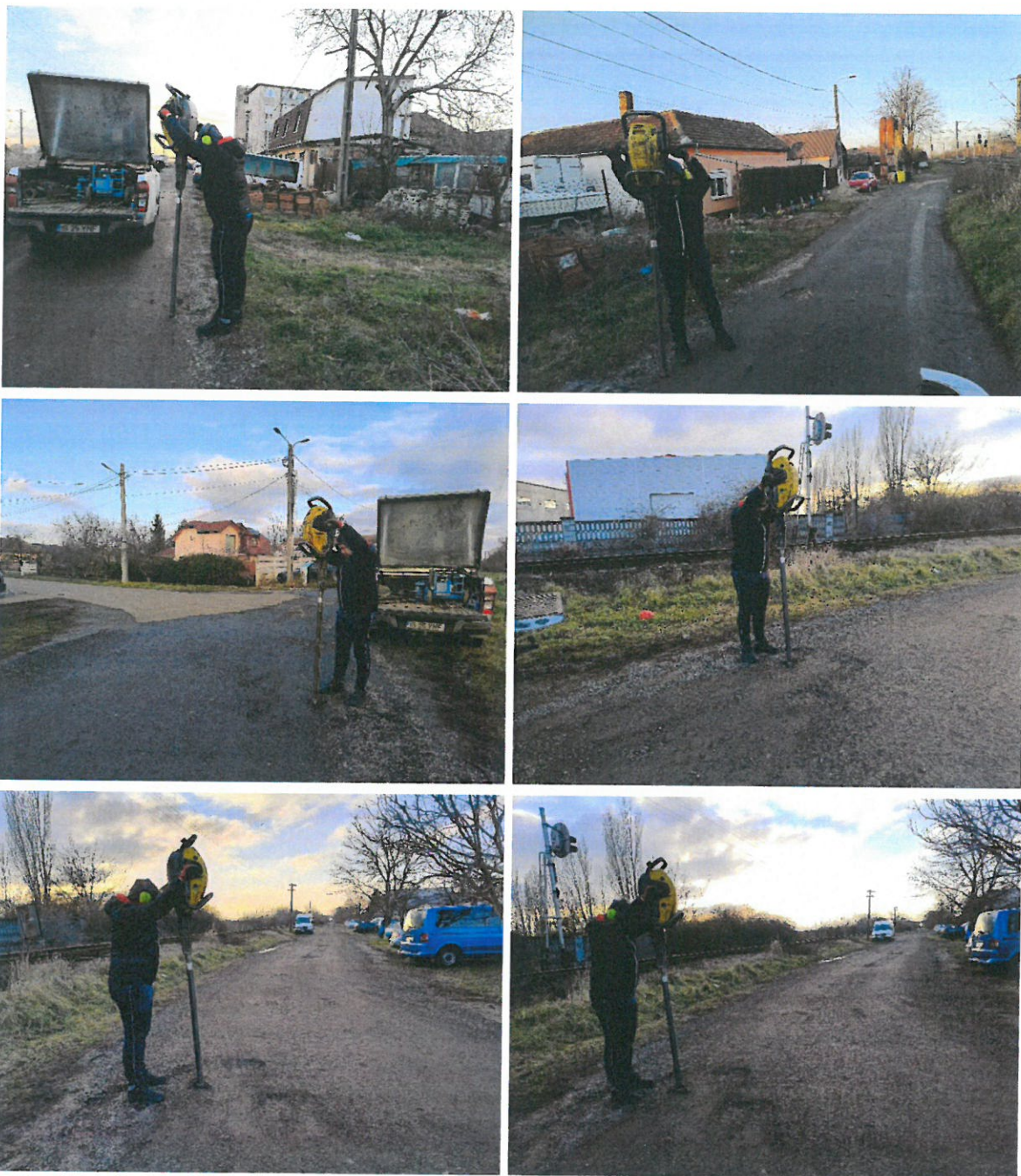
Figura 21. Realizare foraje geotehnice
