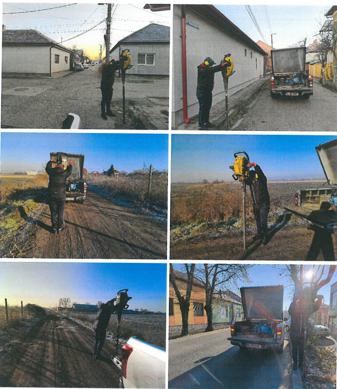
Figura 24. Realizare foraje geotehnice
