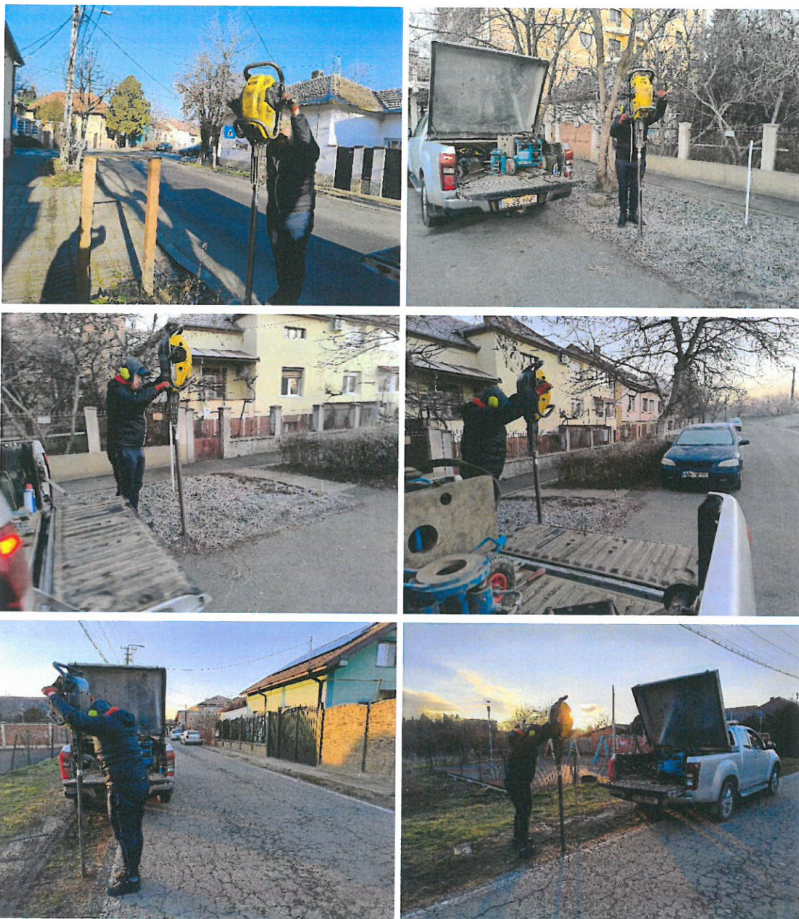
Figura 25. Realizare foraje geotehnice
