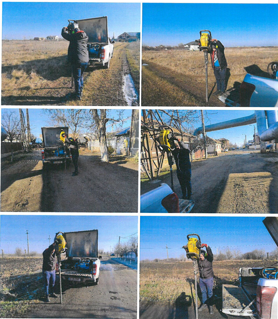
Figura 20. Realizare foraje geotehnice
