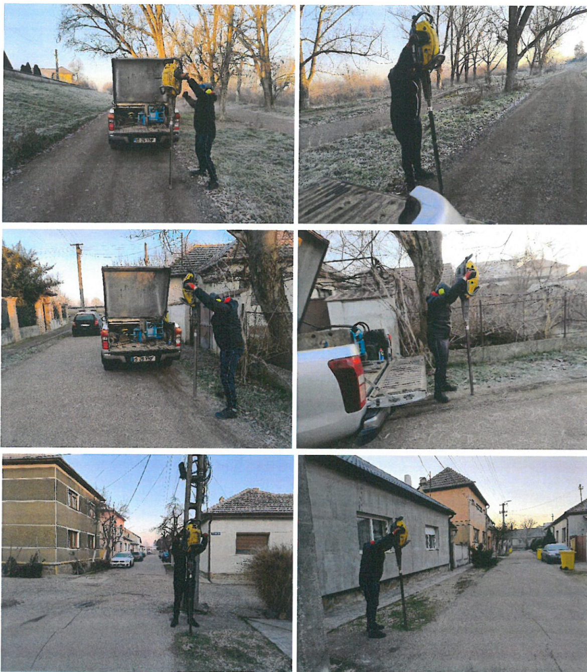
Figura 23. Realizare foraje geotehnice
