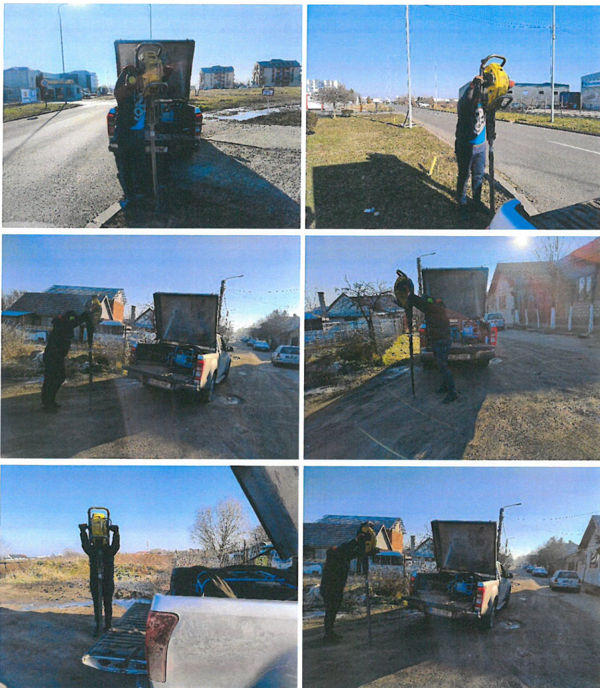
Figura 28. Realizare foraje geotehnice
