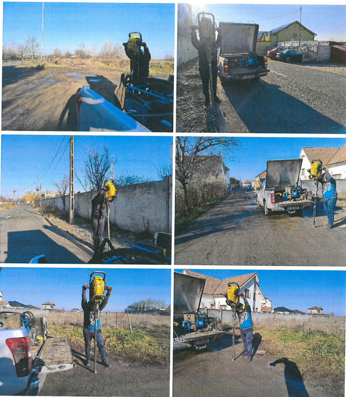
Figura 29. Realizare foraje geotehnice
