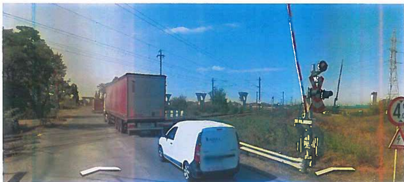
Foto 2 – Trecerea la nivel cu calea ferată existentă
