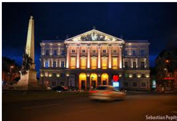
Figura 3-9 – Sistem de iluminat arhitectural – Teatrul Ioan SLAVICI
