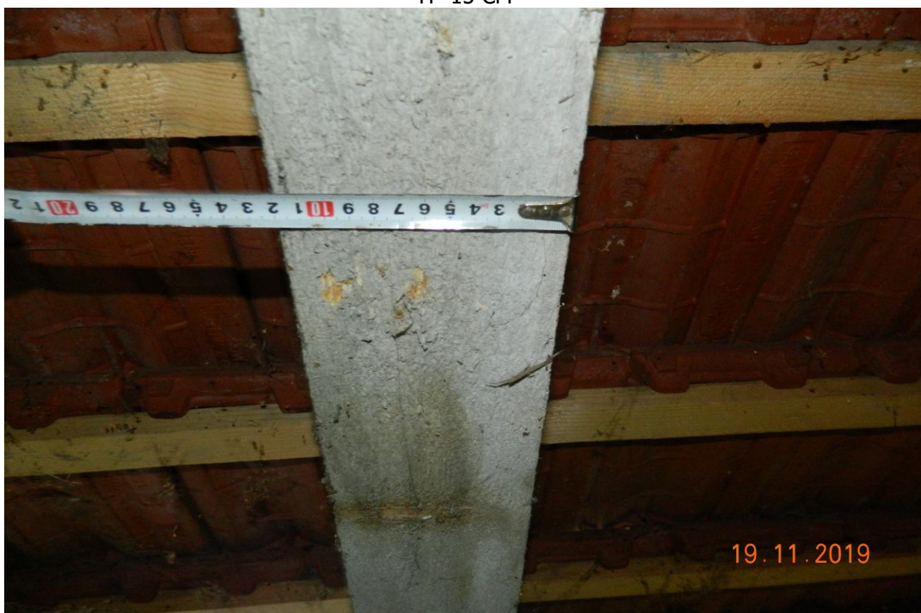
FOTO 14. MĂSURAREA ELEMENTELOR ȘARPANTEI ,LĂȚIMEA CĂPRIORILOR DE 12 CM
