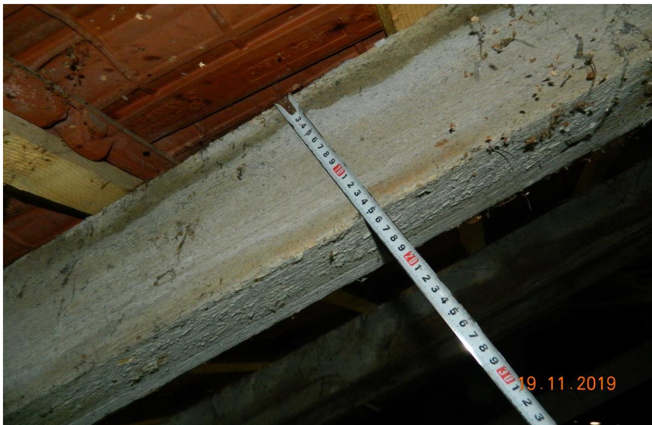
FOTO 13. MĂSURĂTORI PENTRU IDENTIFICAREA ELEMENTELOR ȘARPANTEI, CĂPRIORI CU H=15 CM
