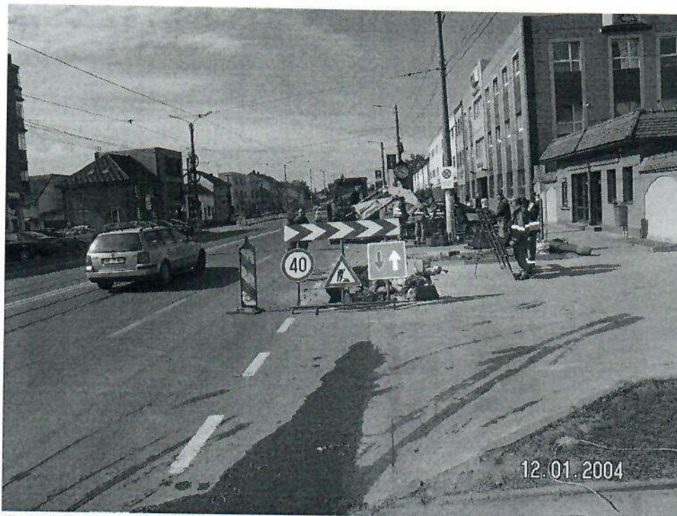
Foto 15 – punct de interventie stradala la retea termica
