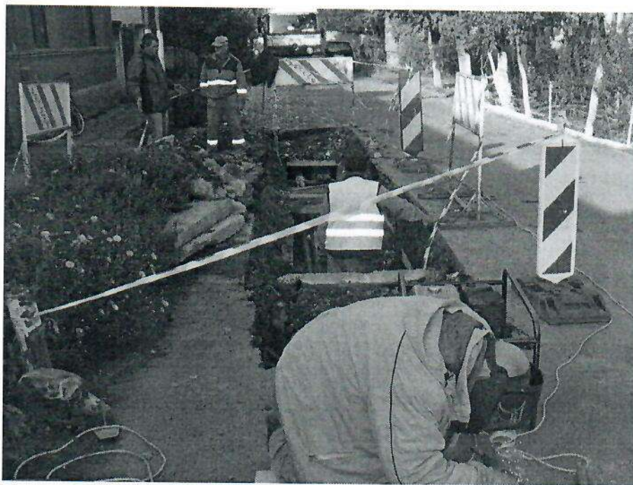
Foto 16 – interventii la retele prin spargeri stradale
