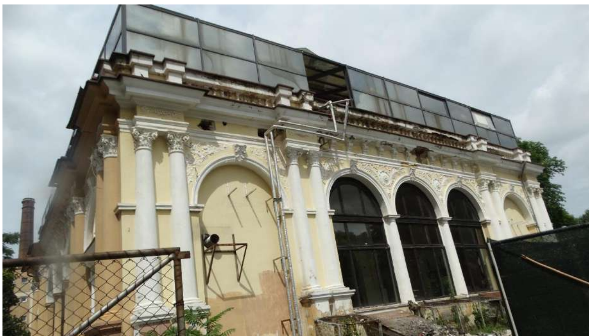
Fațada de est, stadiu actual
