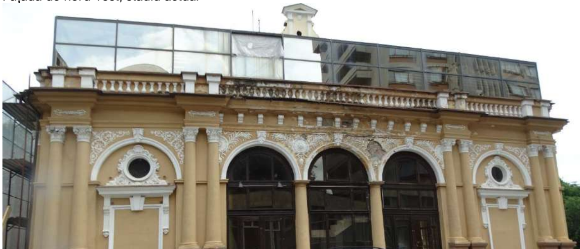
Fațada de sud, stadiu actual
