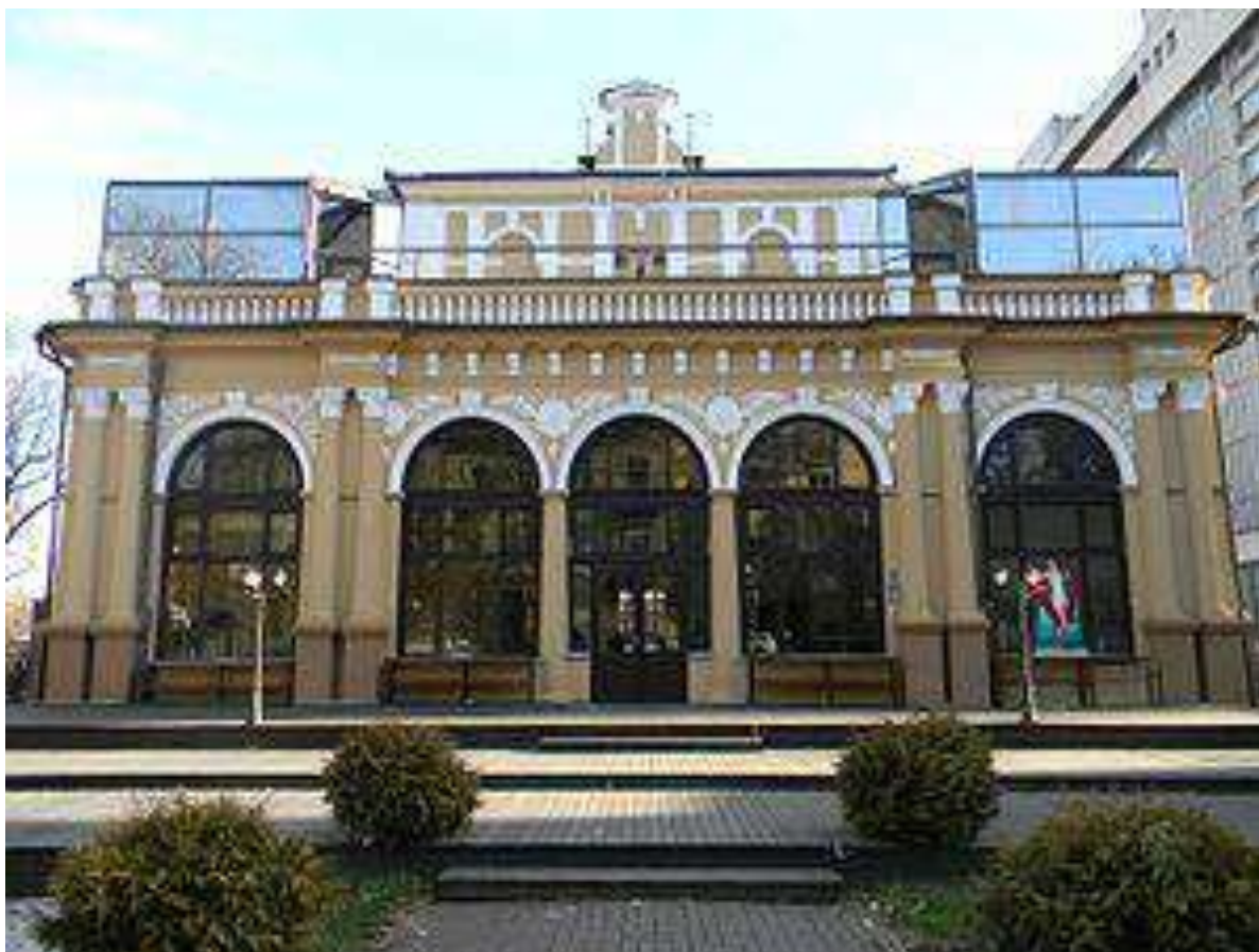
Fațada de vest, stadiu actual
