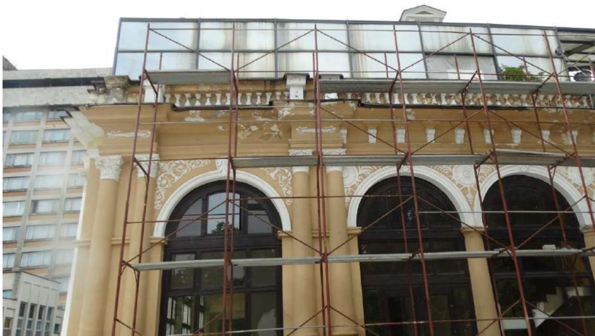
Fațada de nord-vest, stadiu actual
