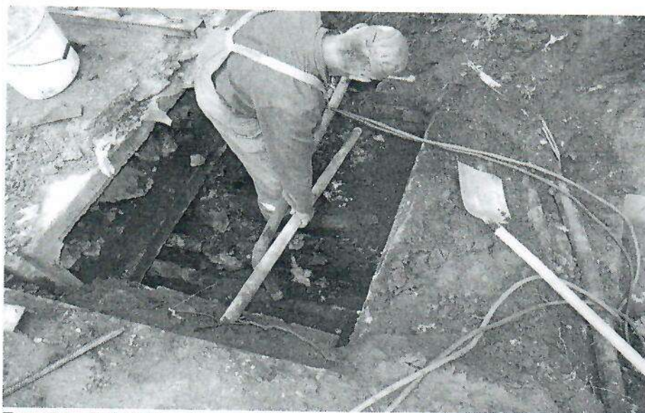
Foto 15 – Retele termice secundar
