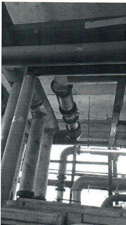
Foto 8 – Detalii cu izolatiile termice
