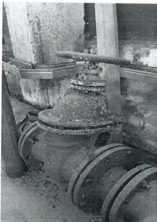
Foto 4 – Detalii de armaturi
