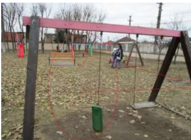
Înlocuire 2 scaune, lanțuri rupte.
