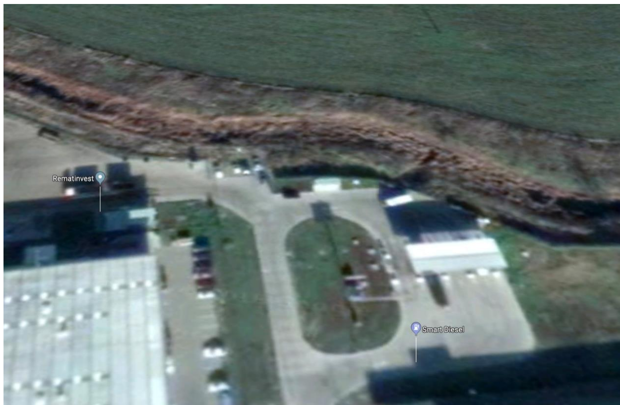
Fig. 4. Zona de capăt a străzii II, în dreptul Canalului CN 1409 (Ier).
