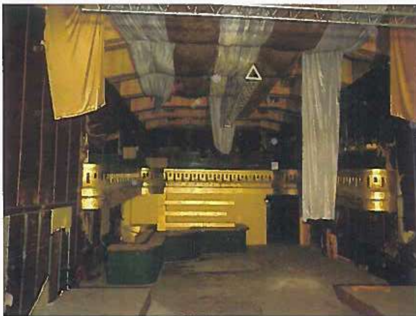
Construcții parazitare improvizate – pult bar, panouri textile pe structură lemn, și materiale textile atârinate de grinzile de beton din planșeu pe structura metalică
