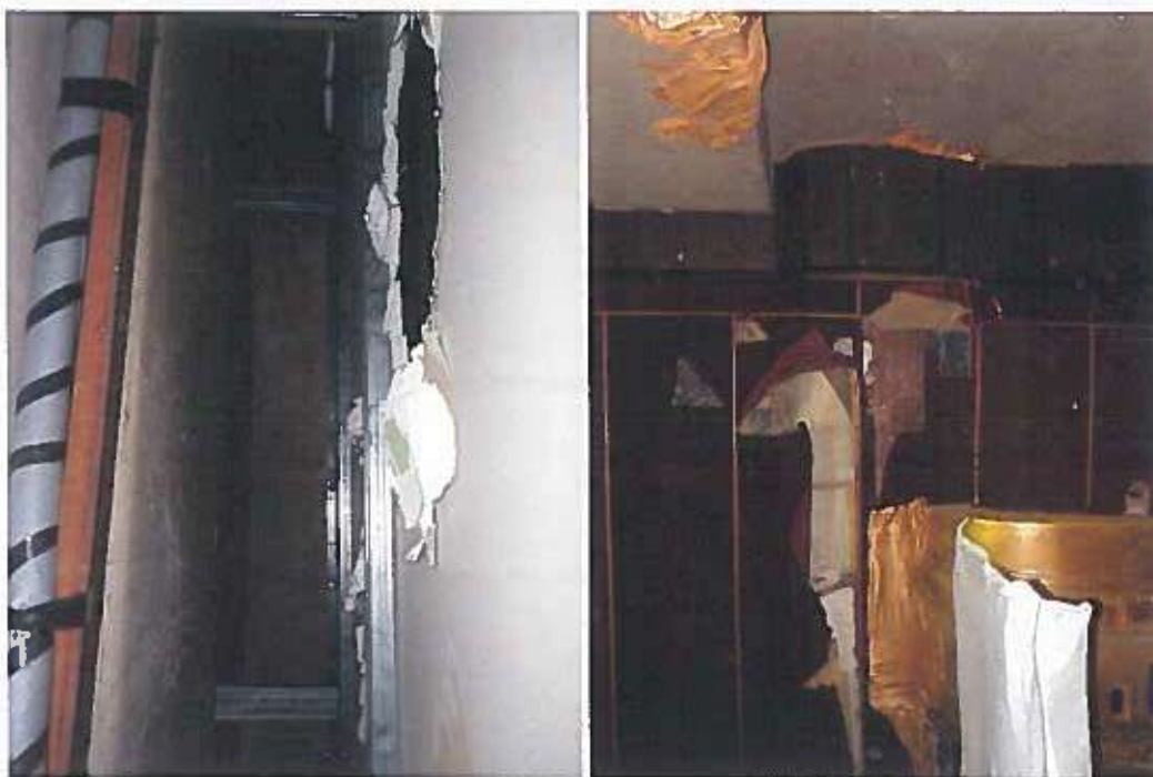
Construcții parazitare - Pereți de gips carton pe structura metalică
