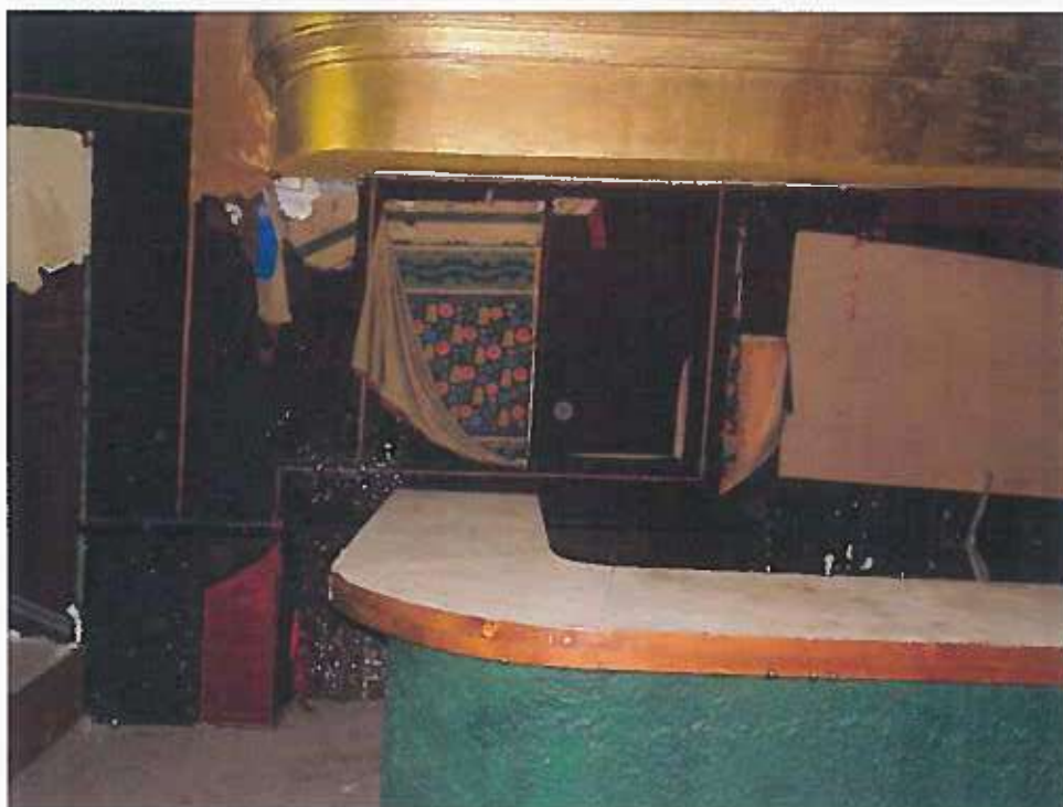
Construcții parazitare improvizate – pult bar, panouri textile pe structură lemn, și materiale textile atârinate de grinzile de beton din planșeu pe structura metalică
