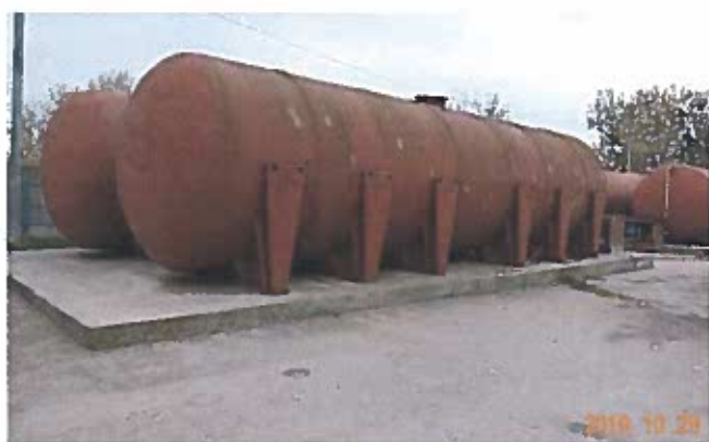
Rezervor suprateran din fibră de sticlă de 100 mc pentru depozitarea clorurii de calciu, nr. inv. 20764
