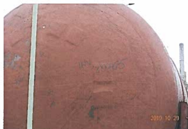
Rezervor suprateran din fibră de sticlă de 100 mc pentru depozitarea clorurii de calciu, nr. inv. 20765
