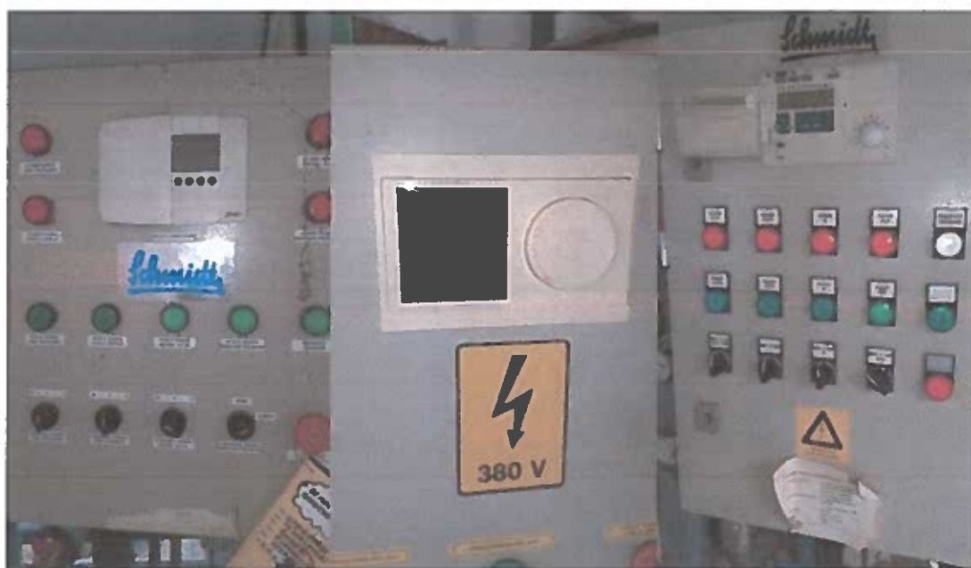
Figura 8: (stânga) controler Danfoss 301, (mijloc) controler Danfoss 310, (dreapta) controler SIEMENS
