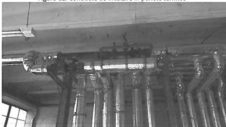
Figura 22: Conducte de încălzire în puncte termice
