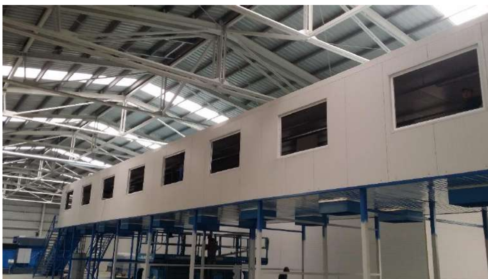
Cabină de sortare – vedere exterioară
