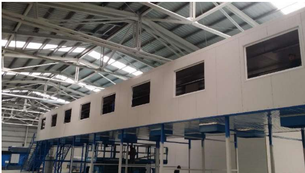
Cabină de sortare – vedere exterioară
