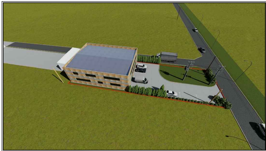
VEDERE AERIANA DINSPRE NORD
