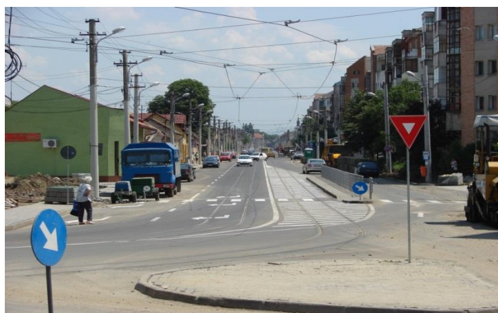
Fig.15. Stație tramvai cu refugiu, str. Condurașilor
