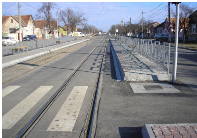
Fig.14. Stație tramvai, str. Renașterii
