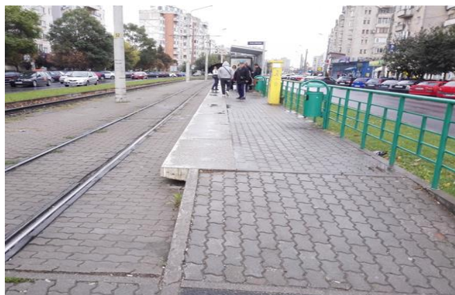
Fig.16. Stație tramvai Calea Aurel Vlaicu
