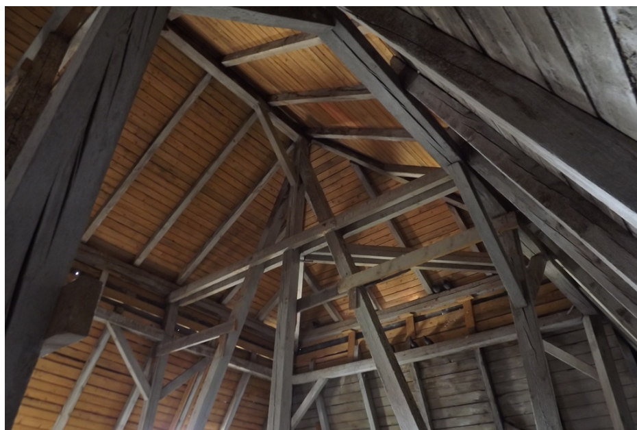
Șarpantă pod în stare bună, zona de învelitoare de ardezie .
