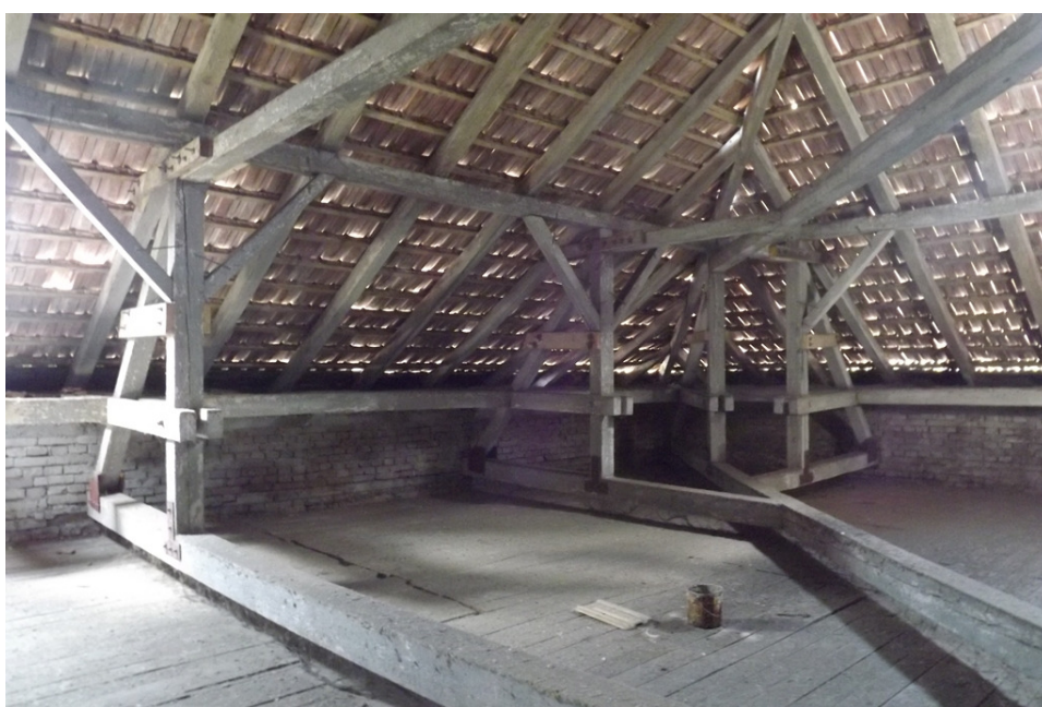
Șarpantă pod în stare bună, zona de învelitoare de țiglă.
