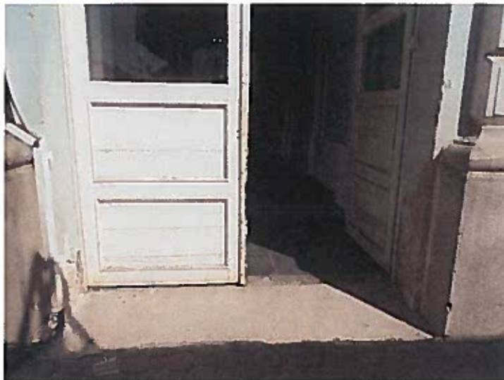
Tâmplărie înlocuită necorespunzător
