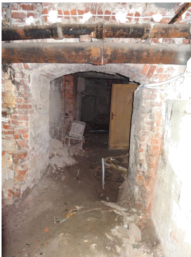
Moloz, nisip, umpluturi parazitare în subsol
