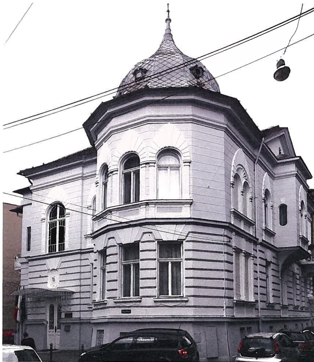
Clădire pe strada Cloșca - sediul Camerei de Comerț, Industrie și Agricultură, fațada
