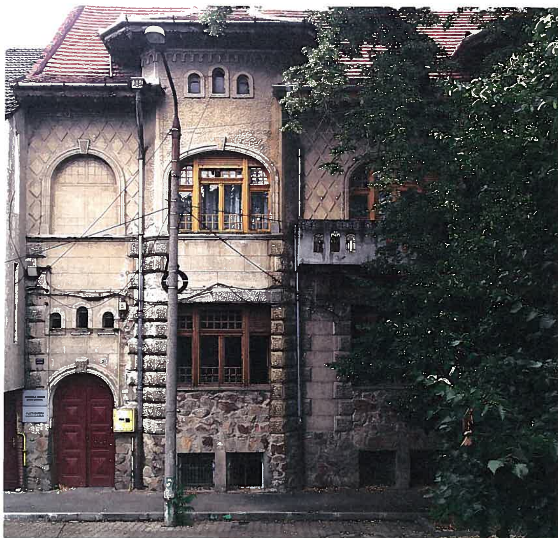
Clădire pe strada Praporgescu, fațada
