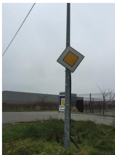
fig. 8/9 , intersecție str. II cu str. III, indicator pozat greșit, prins necorespunzător
