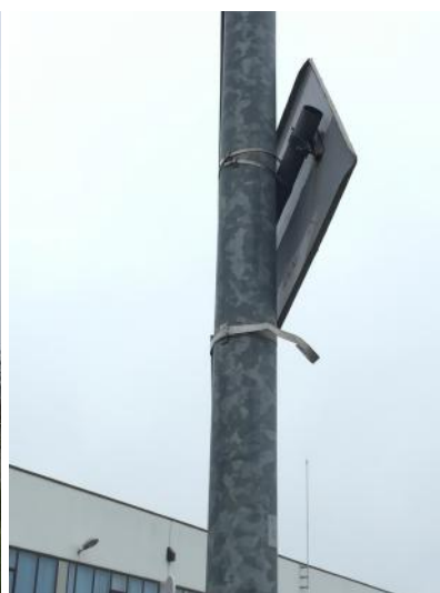
fig. 8/9 , intersecție str. II cu str. III, indicator pozat greșit, prins necorespunzător
