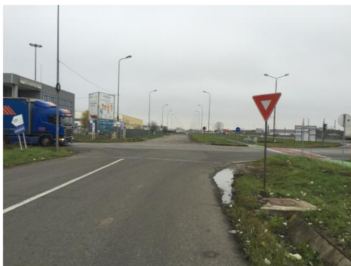
fig. 2, intersecție str. I cu str. II, poziție indicator incorectă
