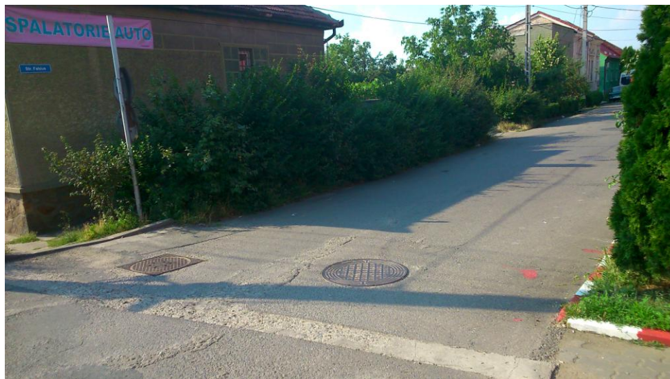
Foto 4 Vedere strada Maximilian
