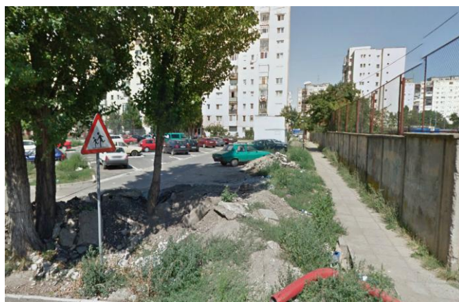
Zona realizare stradă
