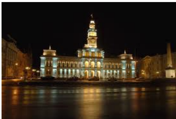
Figura 3-8 – Sistem de iluminat arhitectural – Palatul Administrativ
