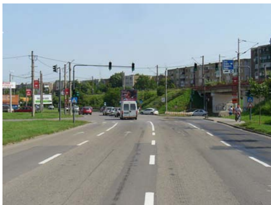
B-dul Nicolae Titulescu la intersecția cu Str. Voinicilor (vedere spre nord)
