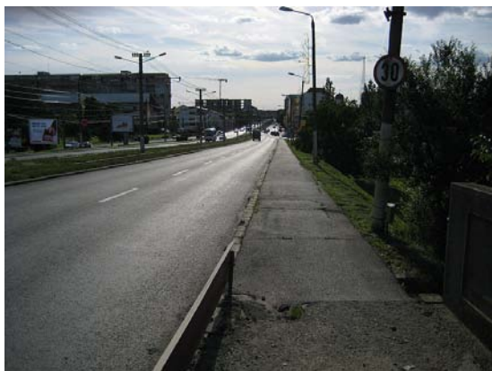
Calea Iuliu Maniu la intersecția cu Calea Radnei (vedere spre vest)
